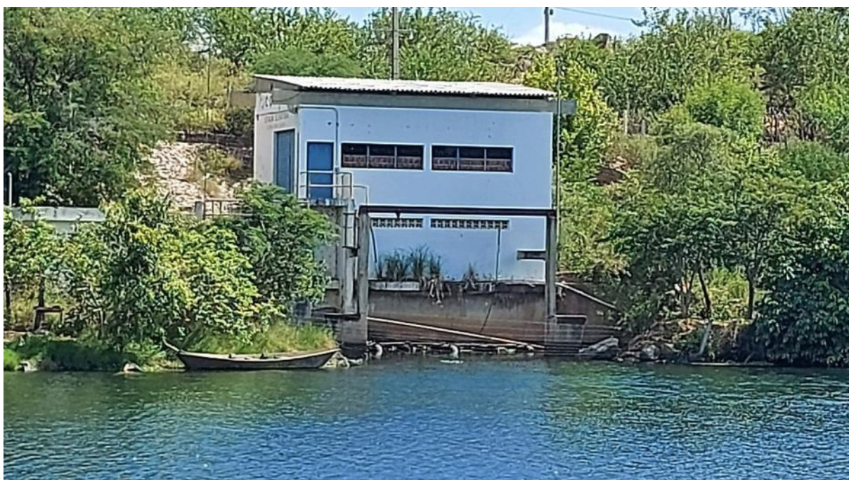
Figura 27 – Captação do Sistema Jatobá / Tacaratu Fonte: Instituto Gesois, 2020.
