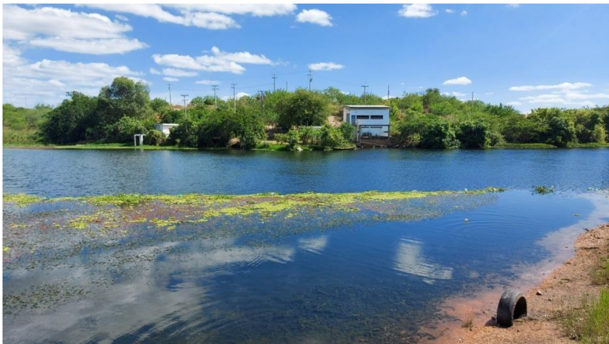
Figura 26 – Captação do Sistema Jatobá / Tacaratu Fonte: Instituto Gesois, 2020.
