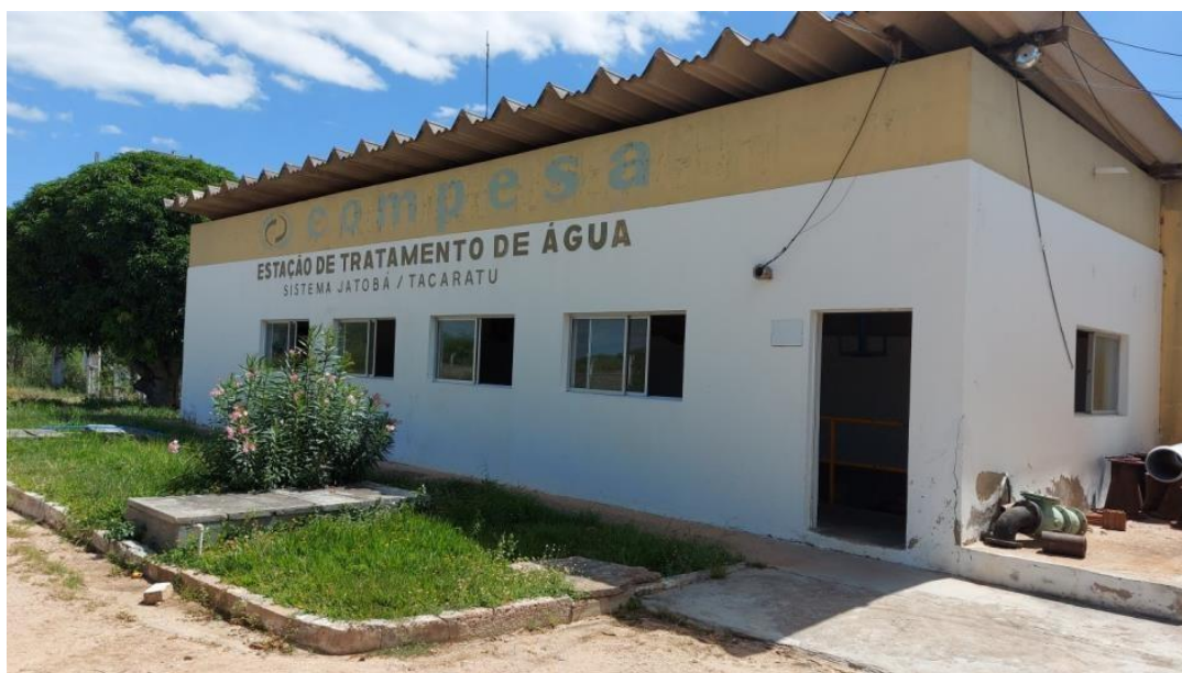
Figura 23 – ETA do Sistema Jatobá / Tacaratu (COMPESA) Fonte: Instituto Gesois, 2020.
