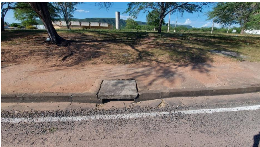
Figura 38 – Vias Urbanas do Acampamento da CHESF Fonte: Instituto Gesois, 2020.
