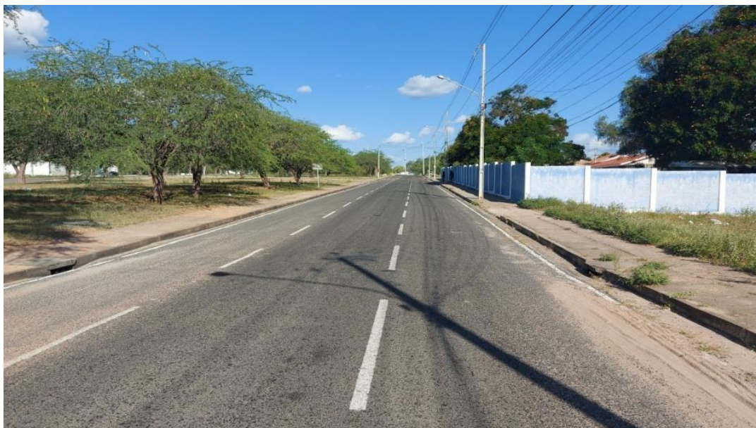
Figura 39 – Vias Urbanas do Acampamento da CHESF Fonte: Instituto Gesois, 2020.
